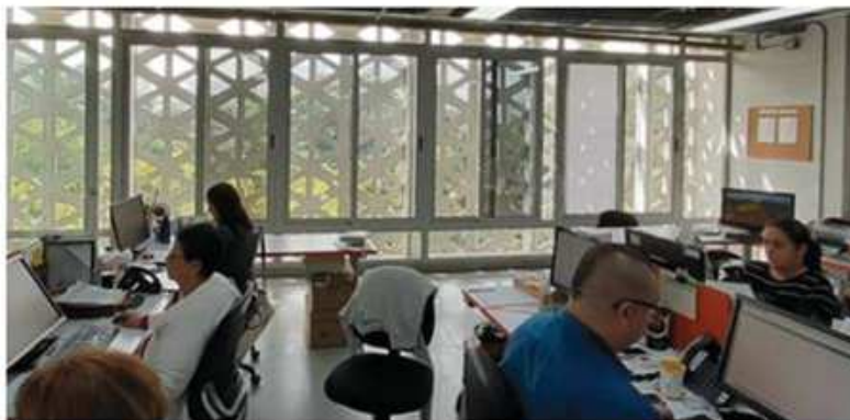
Figura 2 - Fachada interior con ventanas corredizas de operación manual y una segunda piel de paneles prefabricados de GRC (Glass Reinforced Concrete) blanco y un patrón triangular homogéneo para todas las orientaciones.
