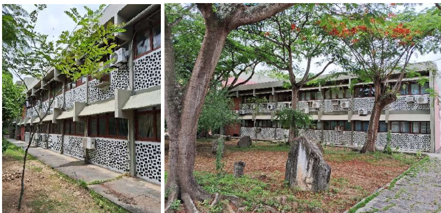
Figura 1: foto do bloco CM da UFCG
