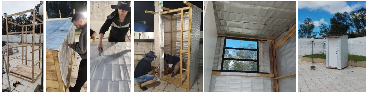
Figura 5: Construção do protótipo
