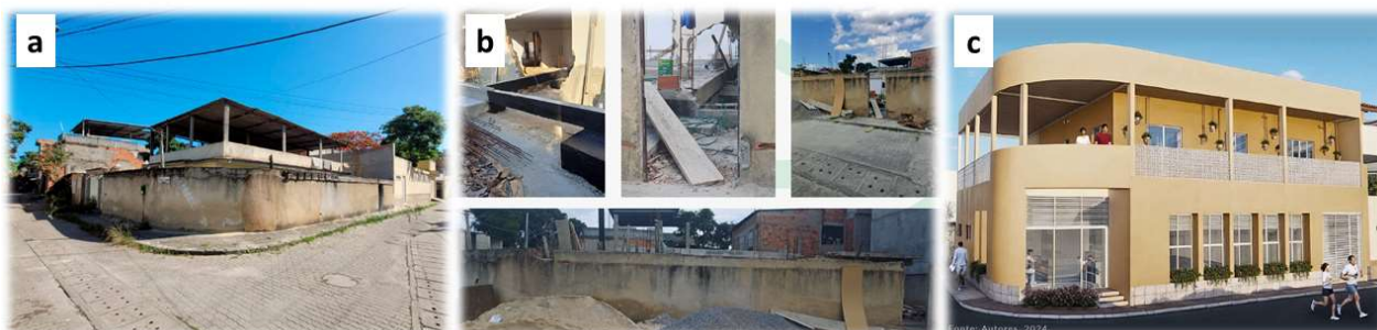
Figura 2: (a) Residência original; (b) demolição da residência; (c) projeto da academia e nova residência.
