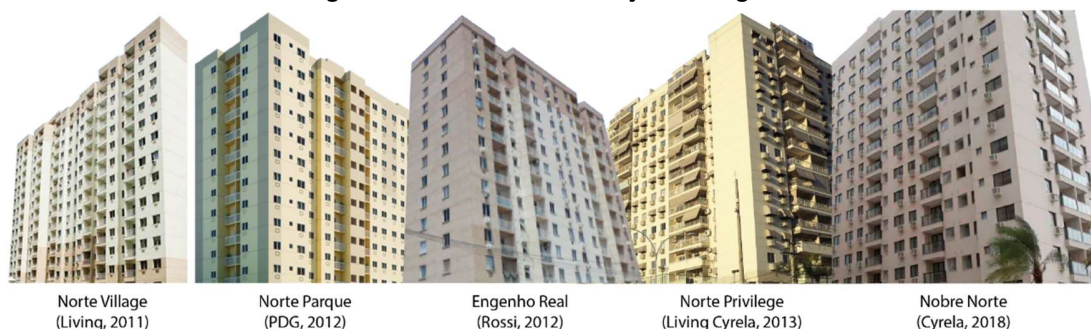
Figura 1: Fachadas das edificações da região.
