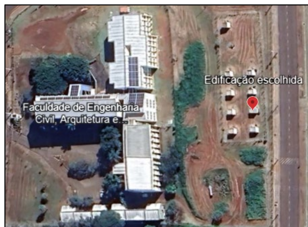
Figura 1: Localização da edificação
