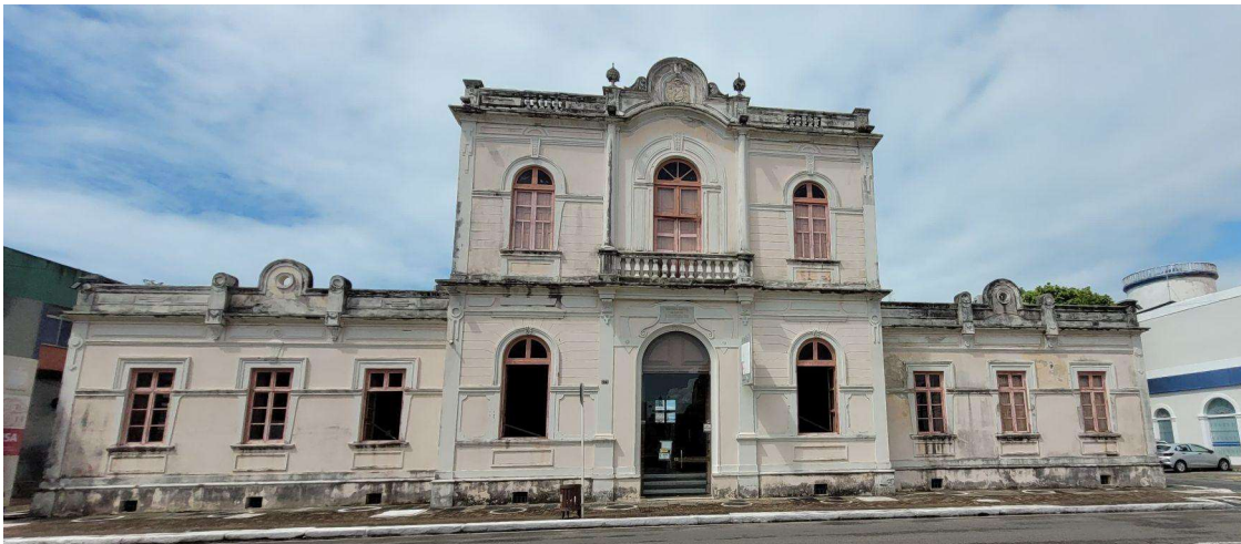
Figura 1: Fachada frontal do Museu da Imagem e do Som de Alagoas.
