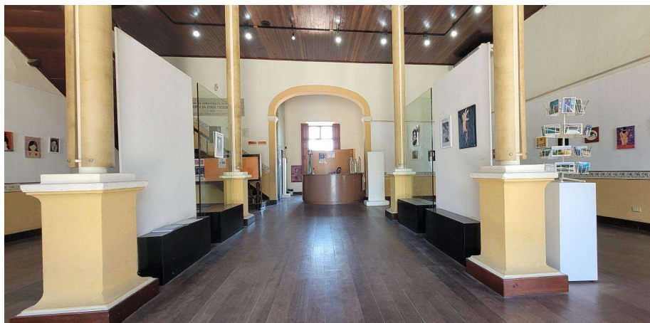
Figura 8: Térreo com livre circulação e ausência de piso tátil direcional e alerta - balcão de informações ao fundo.
