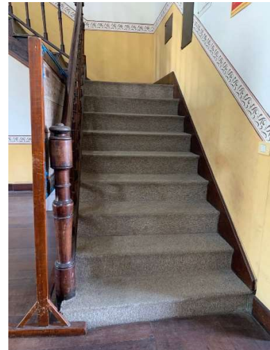
Figuras 14, 15 e 16: Degraus na entrada; bancada com altura desconfortável e escada sem corrimão adequado.
