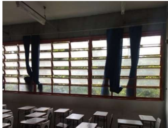
Figura 3: Janela da sala do bloco C34
