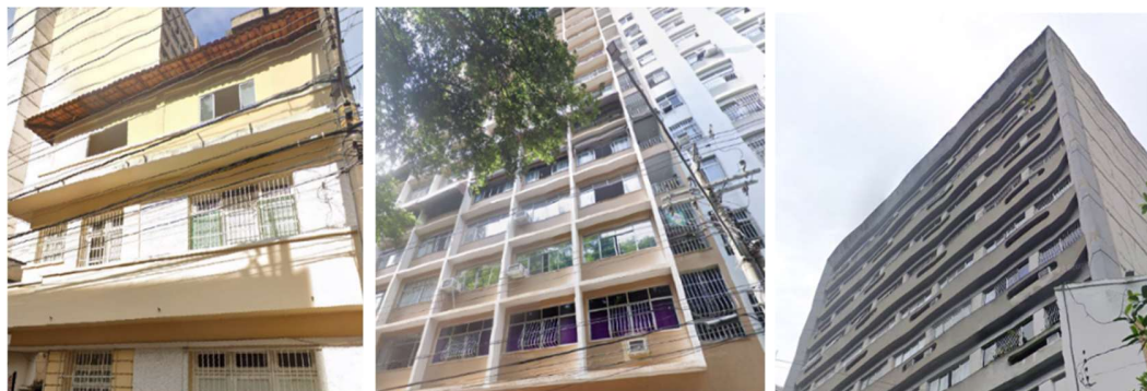
Nota: Da esquerda para a direita: dispositivos horizontais e beiral; dispositivos horizontais e verticais; e área técnica com possibilidade de sombreamento. Fonte: as autoras.
