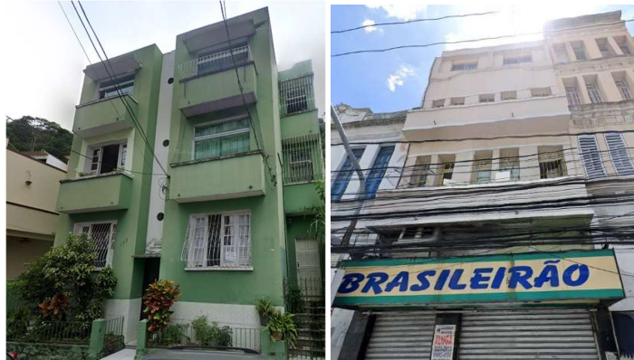
Figura 6: Os dois edifícios que possuem estratégia de elementos vegetados nas fachadas.
