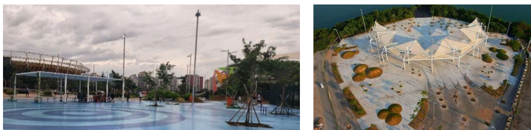
Figuras 4 e 5: Vista das árvores jovens, da cobertura em estrutura metálica e telha policarbonato na área infantil (à esquerda) e do Live Site (à direita).
