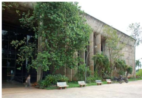
Figura 3: Fachada Principal Bibliotecas Central da Universidade de Brasília
