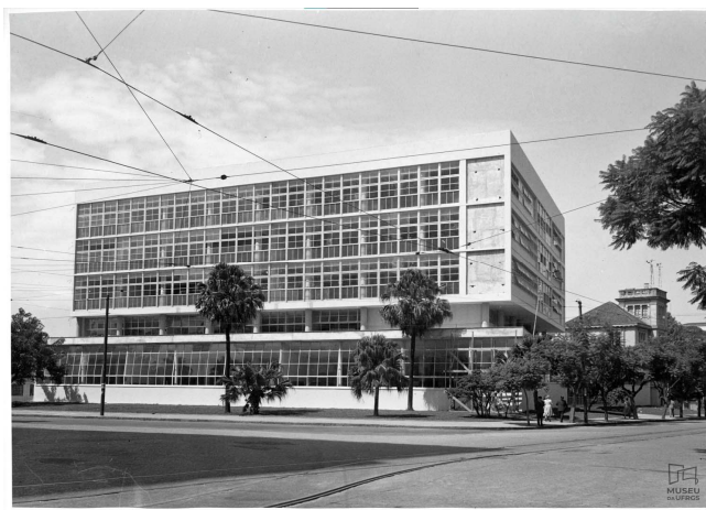
Figura 1: Fachada Nordeste da Faculdade de Arquitetura da UFRGS, anos '60.
