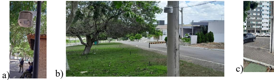
Figura 2: Equipamentos de monitoramento microclimático instalados nas diferentes ZCLs selecionadas: a) No Corredor Verde Dom Constantino Luers, b) No Residencial Sierra e c) no Residencial Espace.
