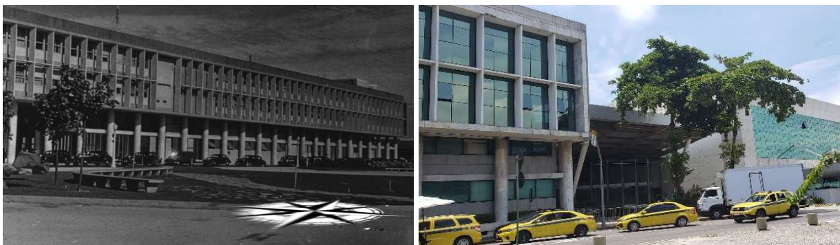
Figura 1: Brises da fachada no ano da construção e brises na fachada atual, após remoção
