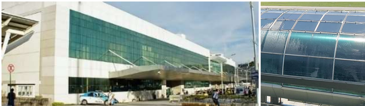
Figura 3: Terminal de passageiros de 2007 e tubulação instalada para distribuição de água na sala de embarque
