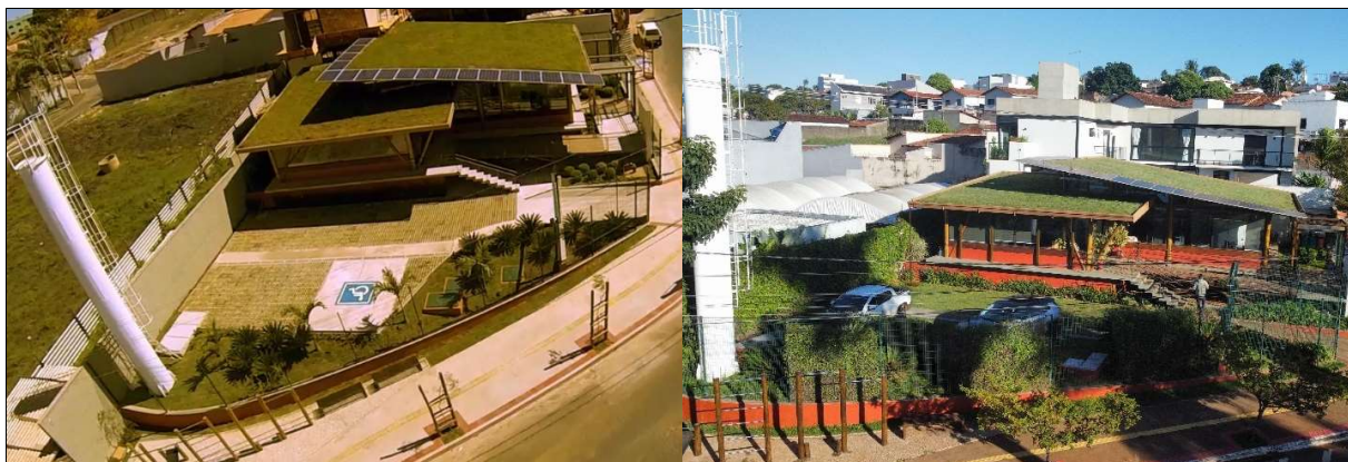
Fig. 1 Fotos de drone, sendo A) No início da ocupação do prédio (em 1º de setembro de 2015) e B) Após 8 anos de utilização da ECS (em 30 de agosto de 2023).
