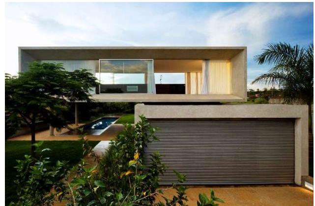
Figura 4: Imagem da fachada Leste.
