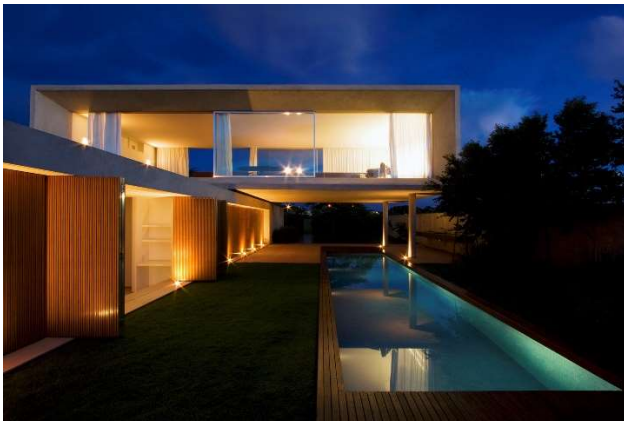
Figura 3: Imagem da fachada Oeste
