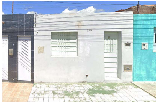
Figura 2: Fachada frontal da residência em estudo.
