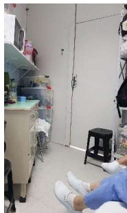
a) Fechamento vertical em madeira e porta de acesso externo (sem privacidade e isolamento acústico)
