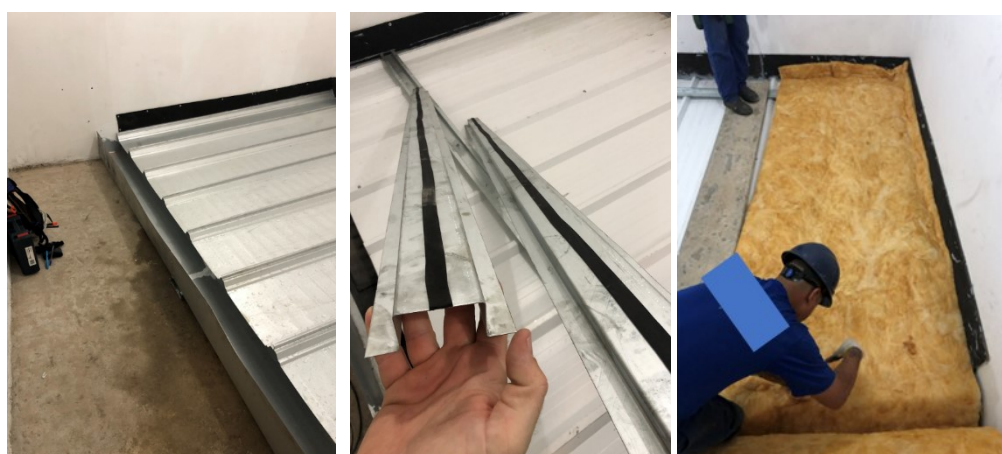
Figura 2: (à direita) Instalação da telha zipada (ao centro) Fita de amortecimento no perfil espaçador (à esquerda) Instalação da lã de vidro para os sistemas compostos
