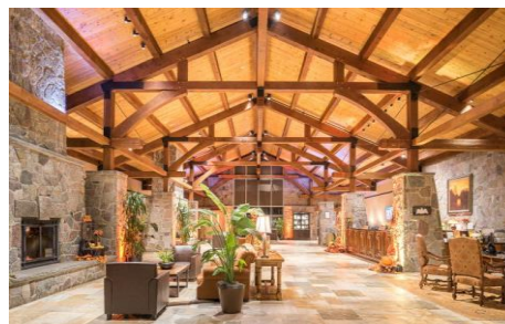
Figura 2 – Estrutura em madeira pesada do Doubletree Hotel
