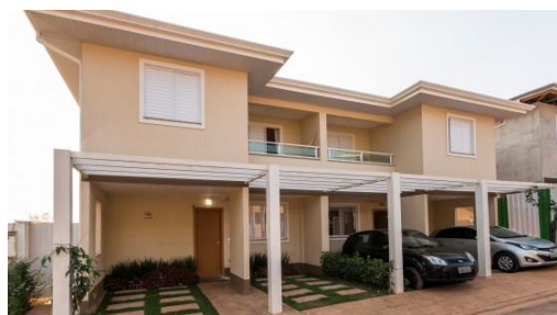
Figura 3 – Residência construída com o sistema Wood Framing
