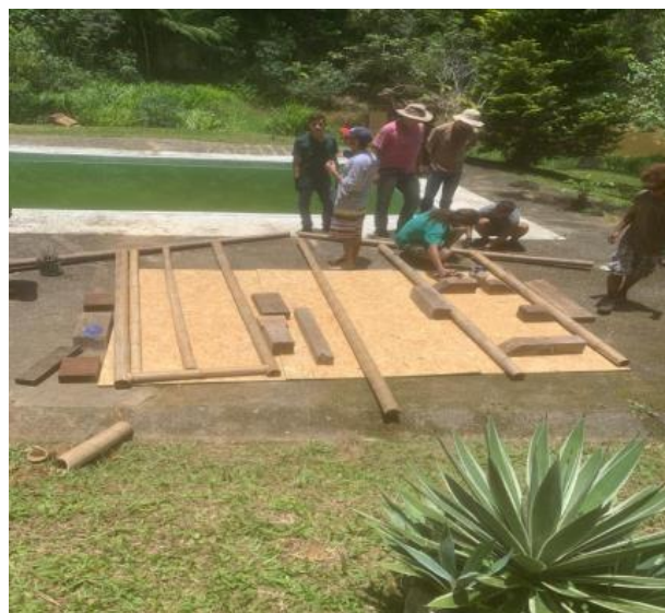
Figura 7 – Construção das Paredes
