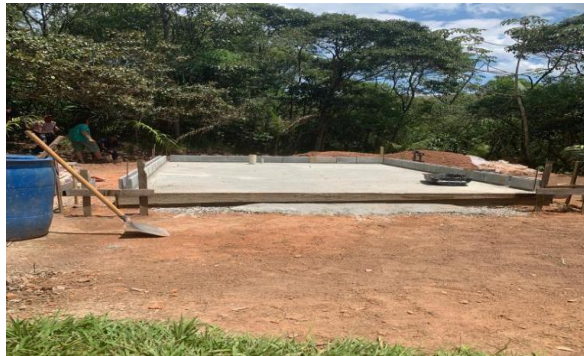
Figura 6 – Construção do Piso
