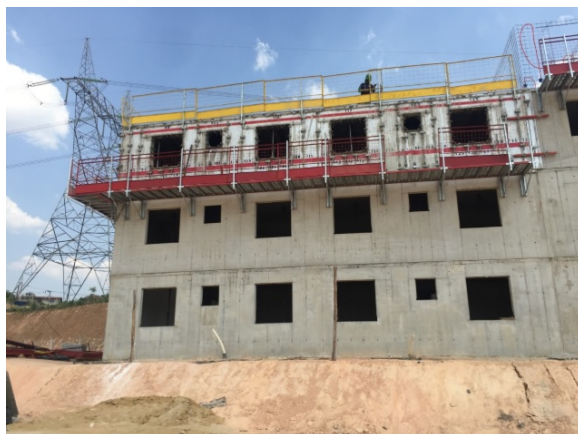
Figura 2 – Vista de uma das torres (obra B)
