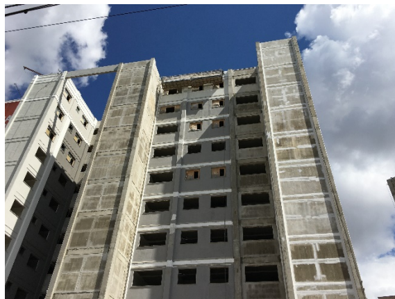
Figura 1 – Vista de uma das torres (obra A)
