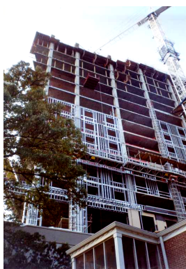
Figura 1 – Vista de fachada com sistema em perfis de steel frame em execução
