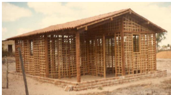
Figure 8 – Locação de pilares e montagem de painéis
