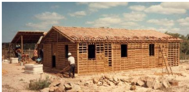
Figure 9 – Paredes sendo preenchidas com argila
