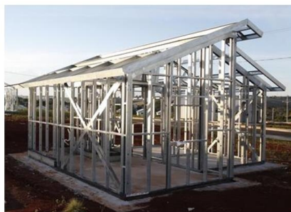
Montagem dos quadros estruturais das paredes e cobertura
