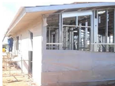
Fechamento da face externa dos quadros estruturais com placas cimentícias
