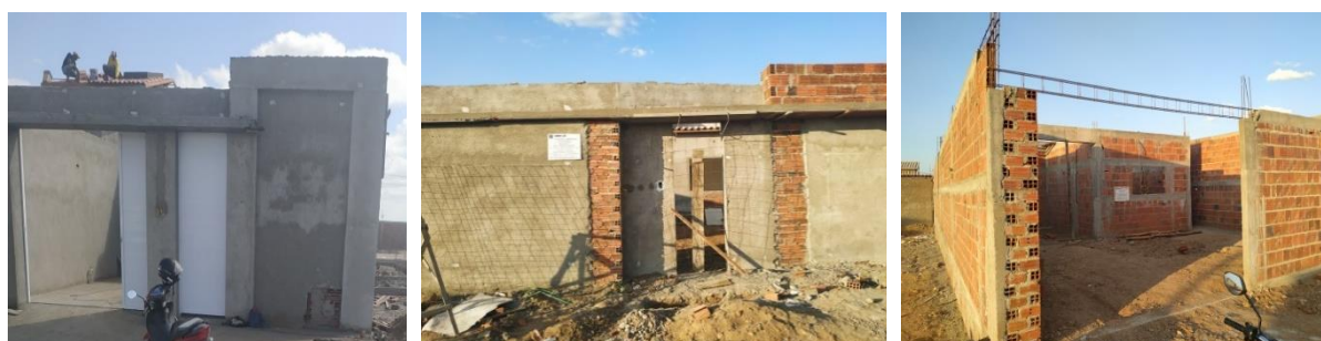
a) Fachada da obra A
