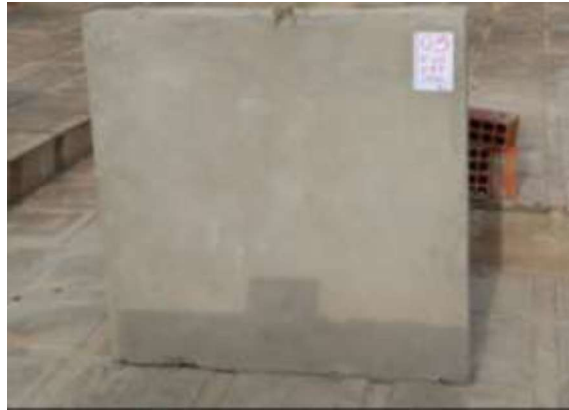
Figura 2 – Parede de alvenaria com 2,50% de adição de EVA
