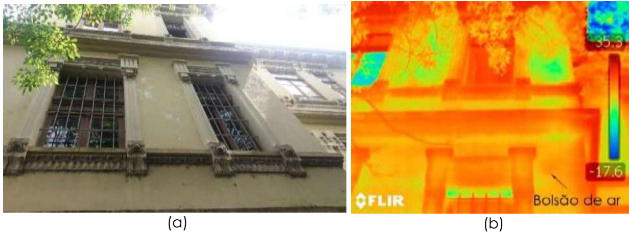
Figura 14 — Detalhe (2) da fachada; imagem real (a) e termográfica (b)
