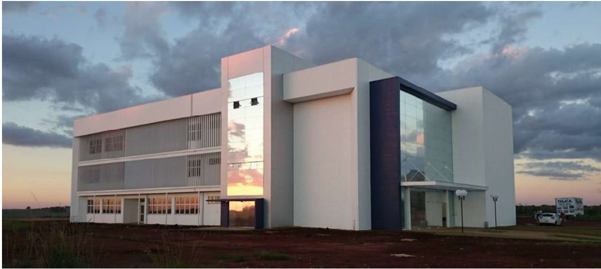
Figura 2. Edifício V2 – vista Sudoeste.
