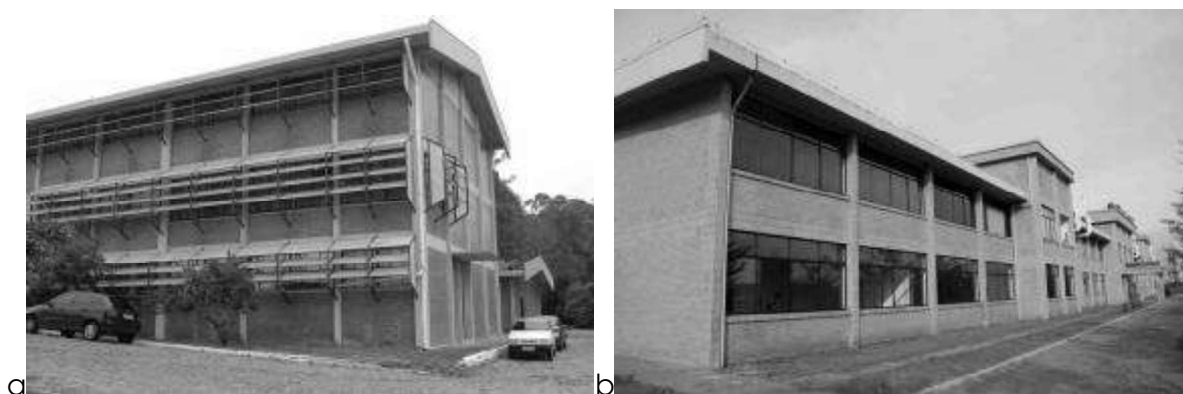
Figura 2. Edifício G1 – Fachada Nordeste (a); Edifício L1 – Fachada Norte (b)
