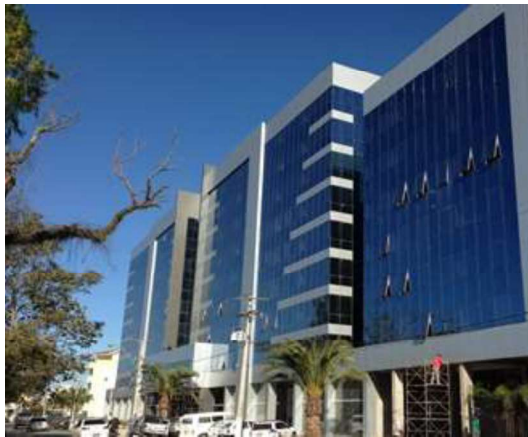
Figura 3 – Imagem do edifício (Fachada NE)
