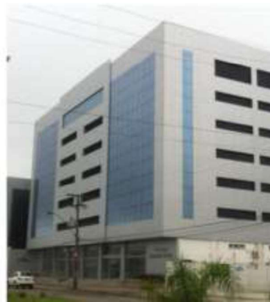
Figura 4 – Imagem do edifício (Fachada O)
