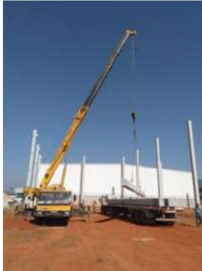
Figura 5: Pilar sendo montado na Obra A.
