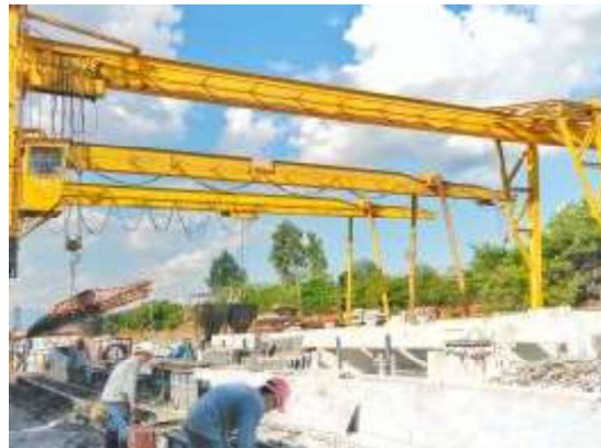
Figura 1: Empresa X - Pórticos rolantes para transporte e armazenamento.
