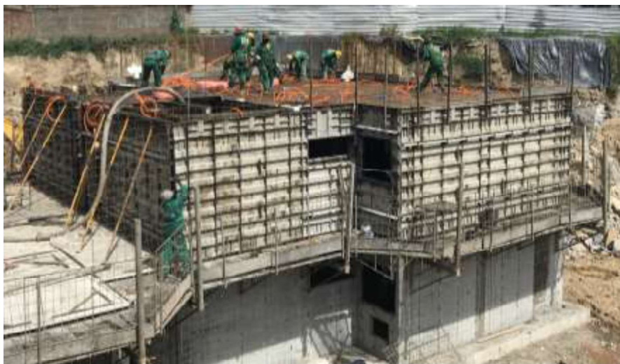
Figura 2 – Montagem de armadura da laje
