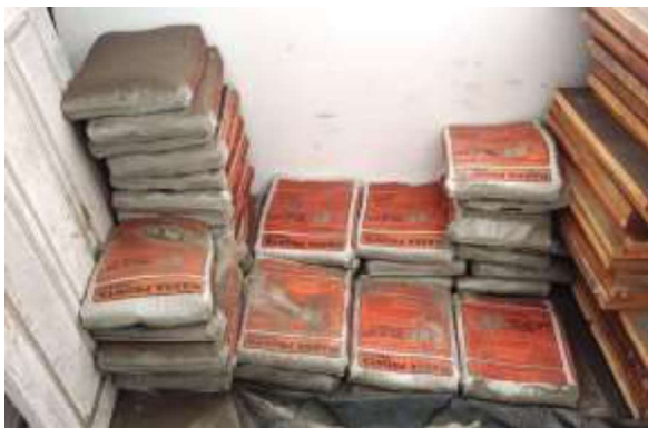
Figura 3 – Estoque de argamassa de assentamento
