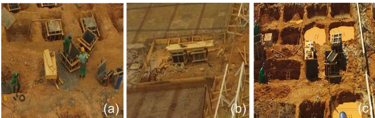
Figura 6 – Bancada de madeira para corte – improvisada, instalada no meio do canteiro.
