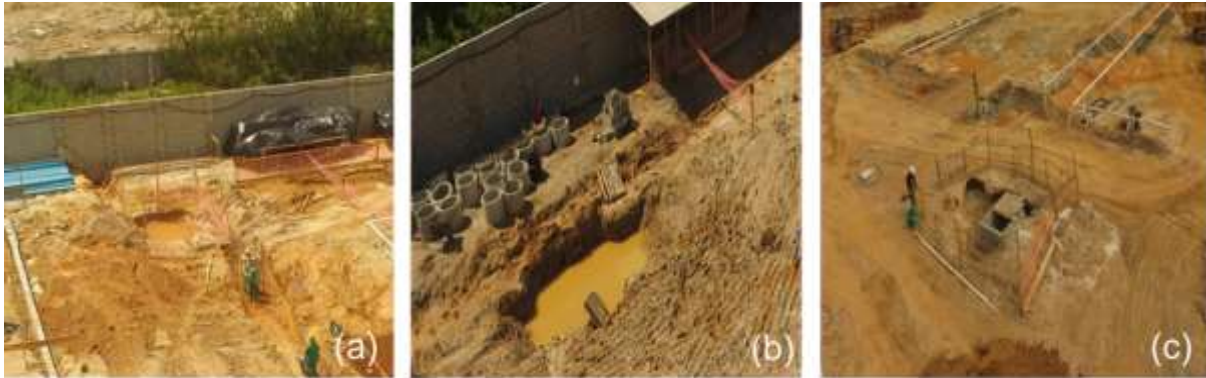
Figura 7 – Isolamento das escavações.
