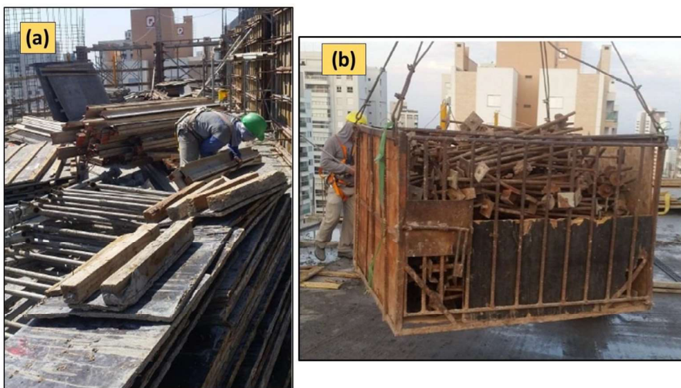
Figura 1 – Transporte e depósito de materiais no pavimento
