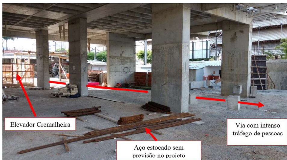
Figura 3 – Áreas de movimentação sem demarcação
