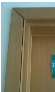
Figura 7 – Alizar rachado
