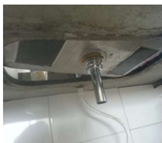
Figura 5 - Vista inferior da pia do descolamento da cuba
