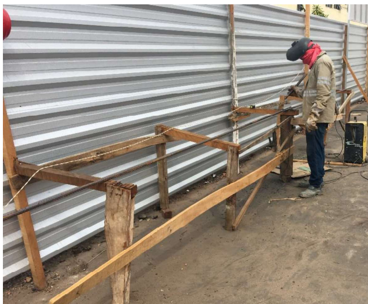
Figura 4 - Execução da solda por traspasse
