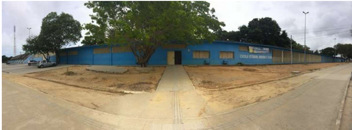
Figura 2: Elementos cobogós e brises na fachada - Escola Estadual Moreira e Silva
