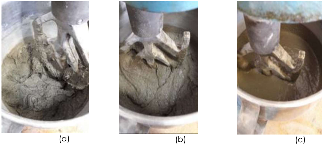
Figura 1- Aspecto de mistura do concreto
