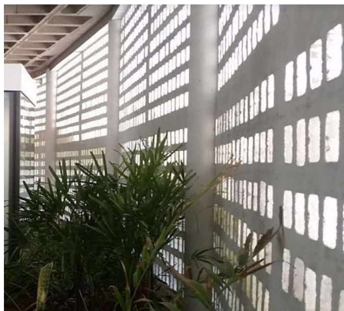
Figura 8 – Resultado da adequação dos cobogós.
