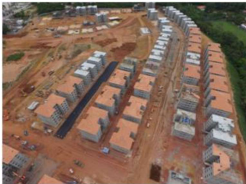
Figura 1 – Canteiro da obra A
