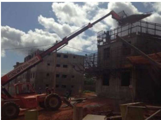
Figura 5 – Transporte de armadura com o manipulador telescópico (Obra A)
