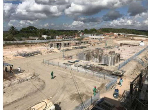
Figura 2 – Canteiro da obra B
