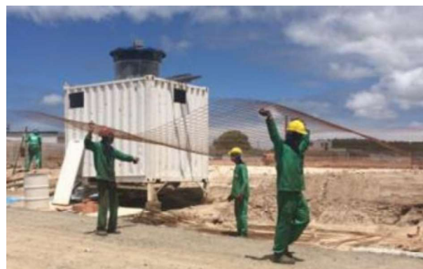
Figura 6 – Transporte manual de armadura (Obra B)
