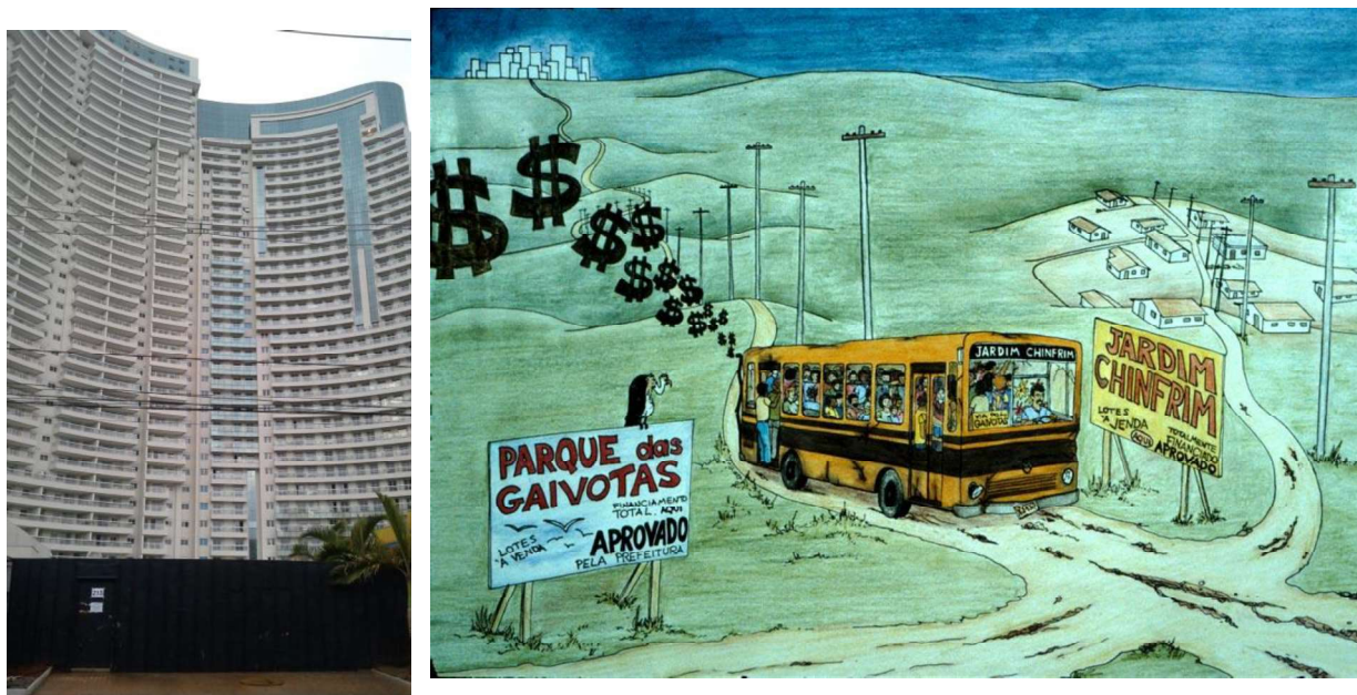
Figura 1 - Densidades construtivas extremas e problemáticas: na esquerda, densidade excessivamente alta, com reflexos indesejáveis nas redes de infraestrutura e serviços urbanos
