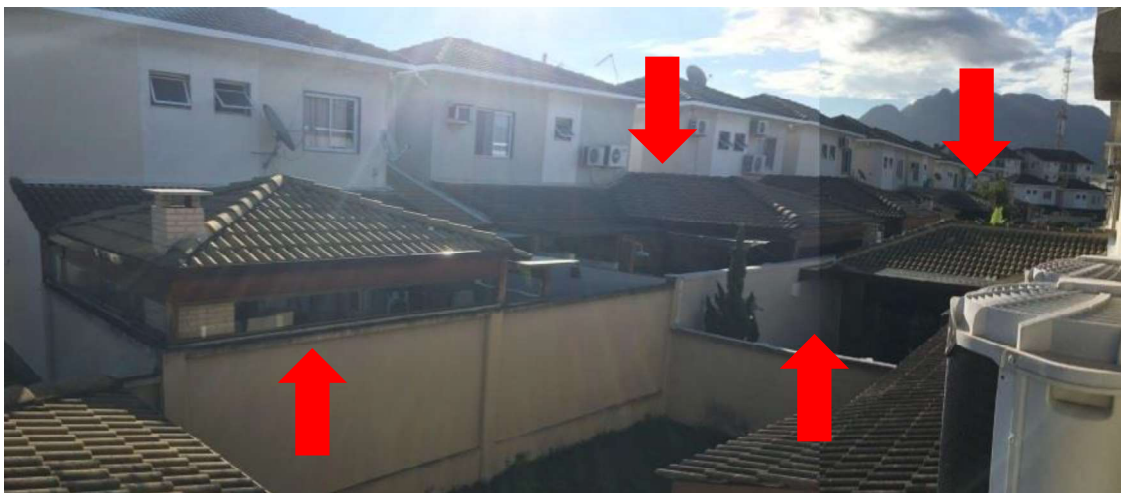
Figura 7 – Acréscimos de área construída nos fundos dos terrenos, destacado nas
