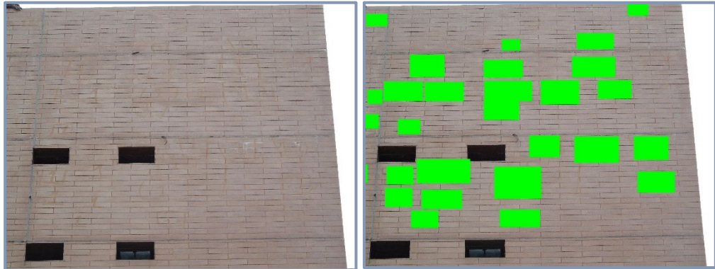
Figura 3: Marcações no Edifício B – Primeira Vistoria
