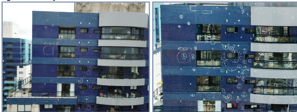
Figura 7: Marcações no Edifício C.
