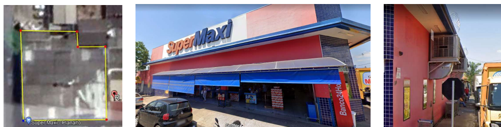
Figura 3 – Exemplo dos registros de imagem para um dos supermercados levantados: vista aérea com demarcação da projeção da cobertura (à esquerda); fachada frontal (ao centro); e unidades de condensação (à direita)
