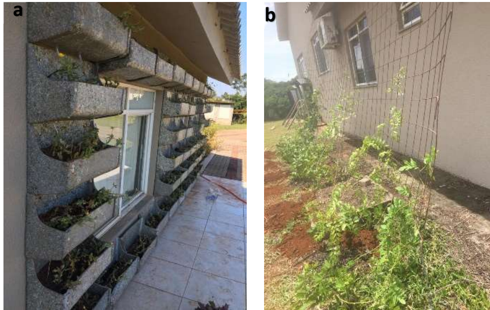
Figura 3: Sistemas verticais de sombreamento utilizados no estudo: (a) parede viva, (b) estrutura da fachada verde.
