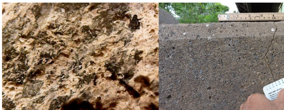
Figura 3: Viga lateral, (a esquerda) foto da lupa (VL4), (a direita) foto normal do pilar.
