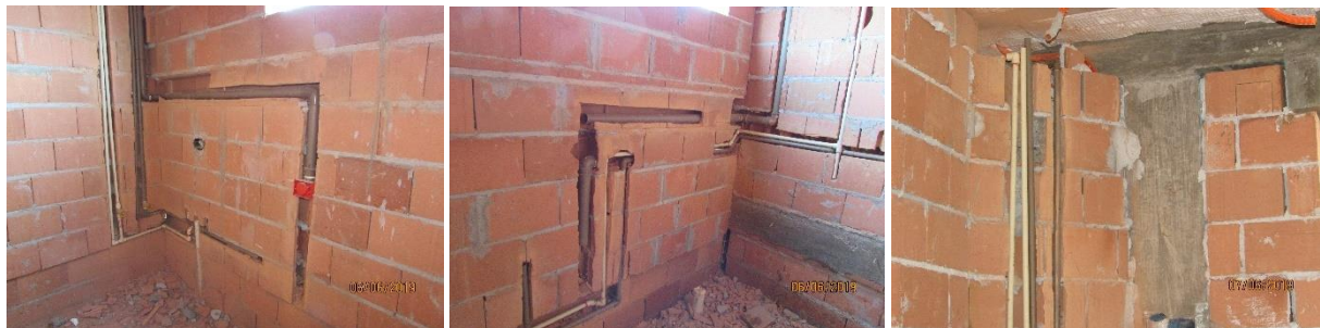
Figura 8: Execução da vedação com recortes para embutir instalações
