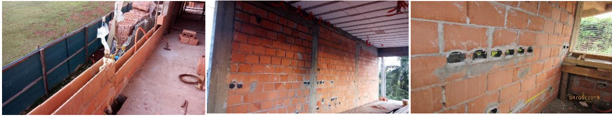
Figura 7: Execução da vedação
